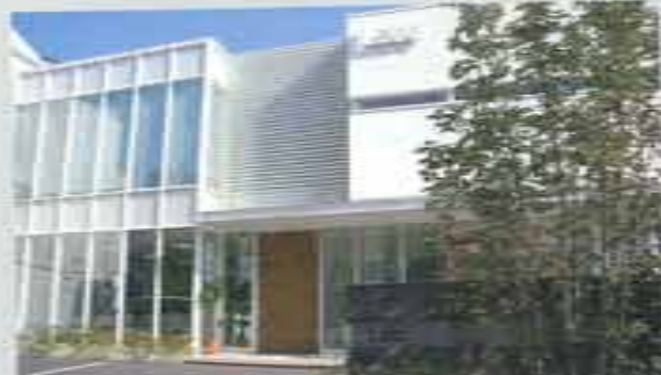
国道1号線沿いの目立つ場所にある住宅空間設計Laboのショールーム。アクセスがスムーズなうえ、広い駐車場があるので安心。近くまで来たついでに立ち寄りましょう
