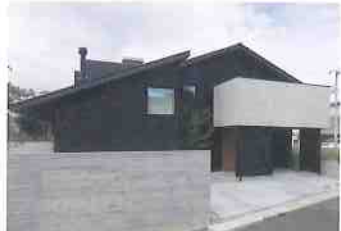
杉板を黒く塗装した外壁や松の無垢材で造作したドアなど、外観も自然素材をたっぷり
