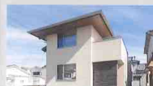
太陽光発電パネルを搭載。玄関はタイル貼りの化粧壁をつけ、防犯性も高めた
