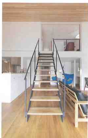
木と鉄を組み合わせた開放感あるストリップ階段は、オリジナルデザインで製作
