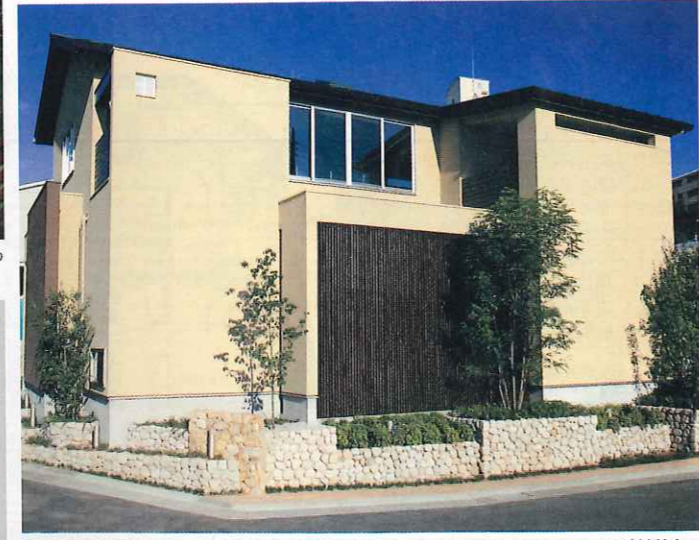
パッシブデザインの観点から窓や格子の位置を計画。神戸気象観測所の風配図より地域特有の方向から吹く卓越風向を解析し、効率よく自然通風を利用できるように設計されている
