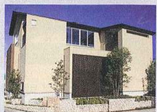
神戸気象観測所の風況図より解析し、効率よく自然風風を利用できるようにした
