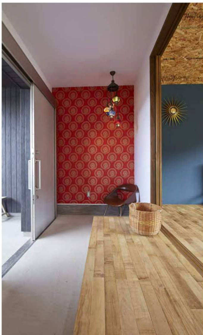
旅先で購入したトルコランプが似合うエキゾチックな輸入壁紙は、Fさんが持ち込んだものを職人が丁寧に施工。土間はモルタルを木コテでざっくりと雰囲気よく左官仕上げしている
