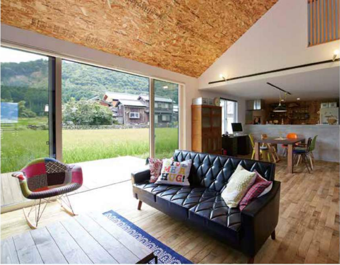
ヴィンテージ感のある木の床、刻印の押された構造用合板の天井…。雑貨屋さんやカフェのようなラフな仕上げに（写真はすべて施工例）
