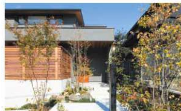
外観にも塗り壁や木の濃淡が美しいレッドシダーの軒など素材の豊かさを採用
